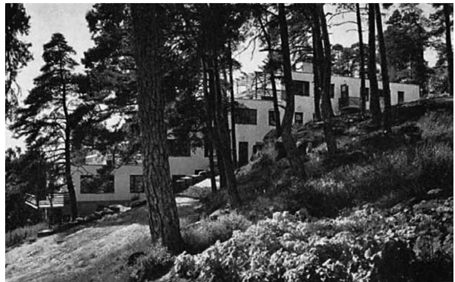
Terrassenhaus in Kauttua
