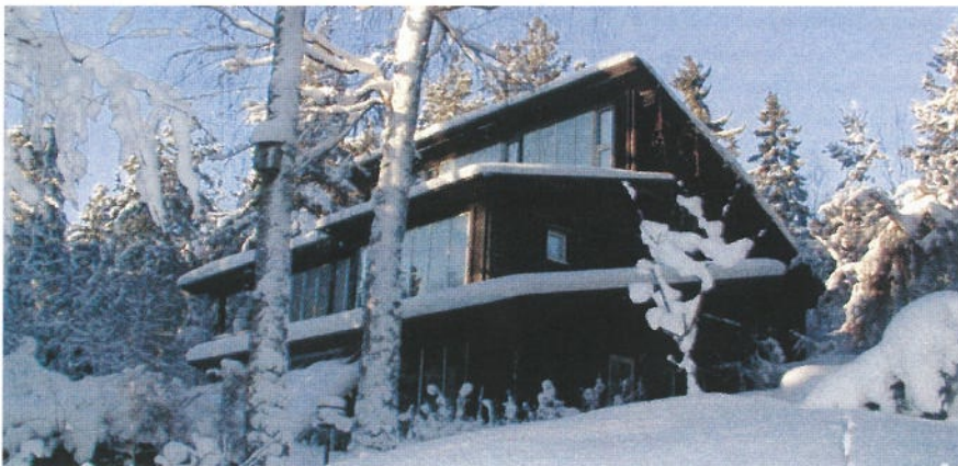
Ökologische Versuchshäuser „Solbranten“. Zwei Häuser in Espoo, gebaut in den 70-er Jahren. Eva und Bruno wohnen in einem davon, welche zu Klassikern der ökologischen Wohnhausarchitektur geworden sind. Eigenschaften: passive und aktive Sonnenenergie, Holzherd, Backofen, Holzöfen, Klimazonen, niedrigster Heizenergieverbrauch aller finn. Wohnhäuser (12 kWh/qm), eigene Wasserversorgung und biologische Reinigung, Gewächshaus und Küchengarten, grosses Grasdach nach Norden.
