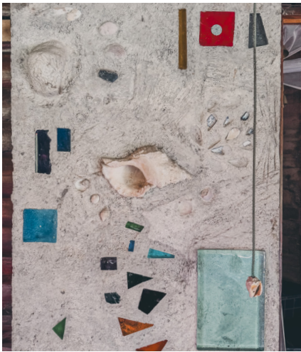
Muscheln und Glas in Betonwand
