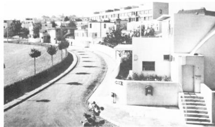
Übersicht von Weißenhof 1927. Im Vordergrund das Haus Scharoun, im Hintergrund das Haus Mies van der Rohe. (Foto: Reproduktion)
